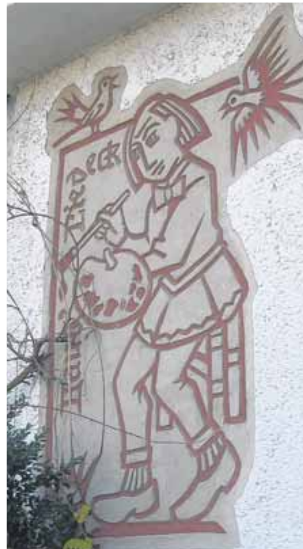
Beim Abriss verschwand zwangsläufig auch das Wandbild, das äußere Wahrzeichen des „Hauses Liedeck“.
